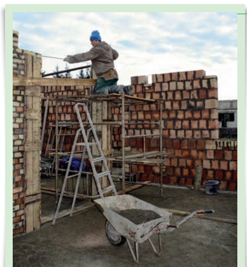
6. Przy murowaniu powyżej wysokości 150 cm stosuje się rusztowania.
